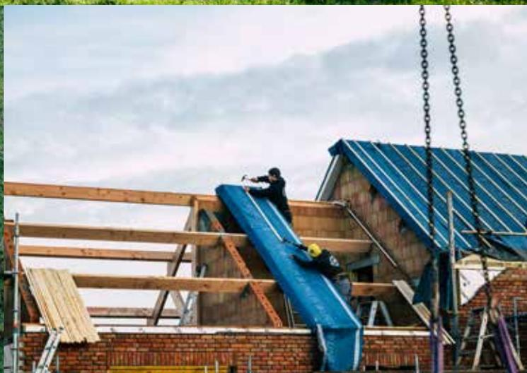
« J'ai opté pour des éléments de toiture PIR de Ussystem en combinaison avec de la laine de verre, car ils offrent une isolation acoustique et une face intérieure déjà finie. »
