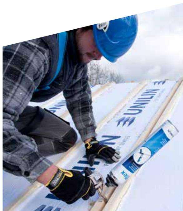
nécessaire ! L'écran rigide et la barrière d'étanchéité à l'air nécessaires sont déjà intégrés dans les éléments de toiture Usystem.
